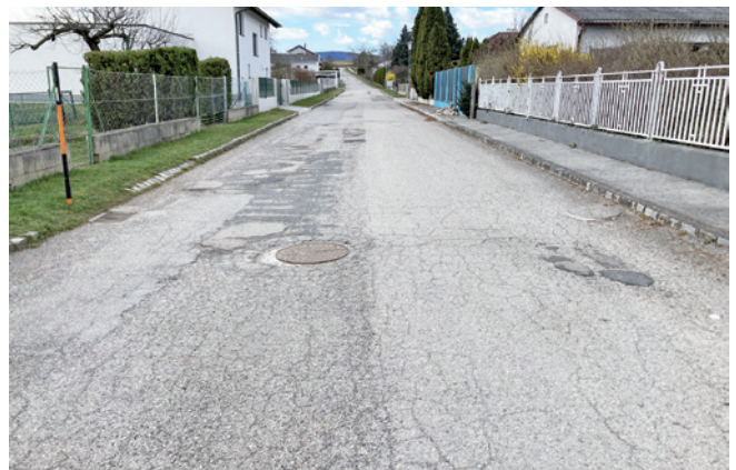
Die Neubaugasse wird eine der nächsten Straßen sein, die saniert wird.
